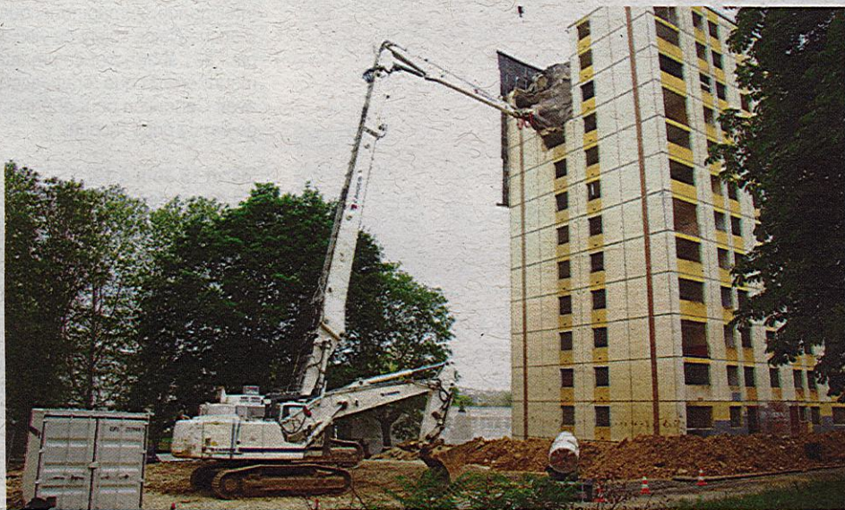
La démolition de la tour a débuté dès 9h le 4 juin (crédit photo Sophie Dussautoir, Nathalie Sibert)
